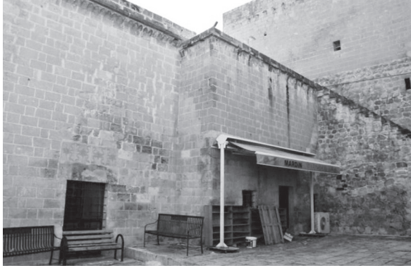
Melik Mahmud cami türbesi giriş cephesi
