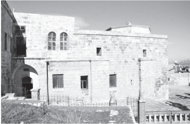
Hatuniye Medresesi ve Türbenin Güney Cepheden Görünüş
