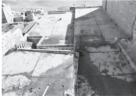
Şehidiye Medresesi Güneydeki Türbenin Üstten Görünüşü
