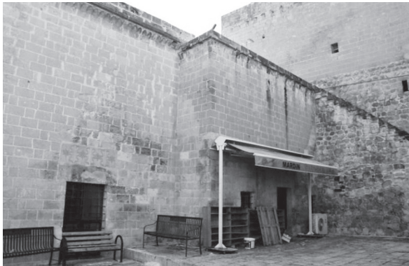
Melik Mahmud Cami Türbesi giriş cephesi
