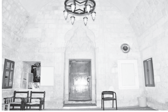
Melik Mahmud Cami Türbesi kuzey duvarının görünüşü
