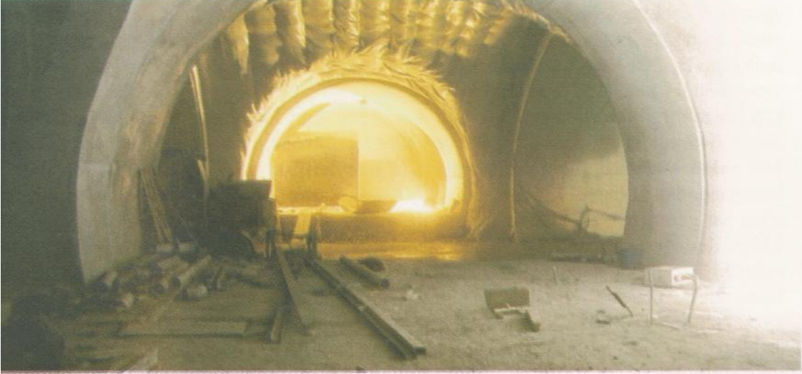
ÜÇYOL İSTASYONU MERDİVEN TÜNELİ
