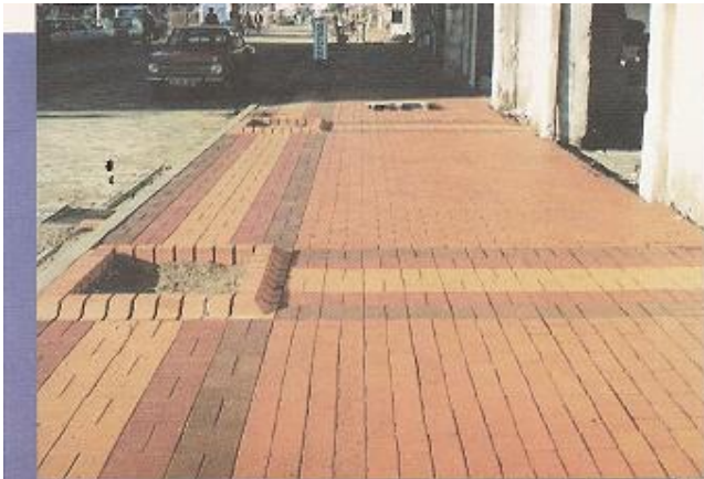
• Gaziemir Önder Cad. Zemin Düzenlemesi
