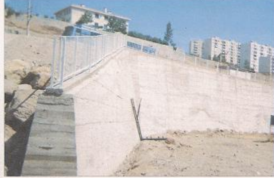
• Egekent 8819 sokak Denizciler Sitesi arkası istinad duvarları çalışmalarından.
