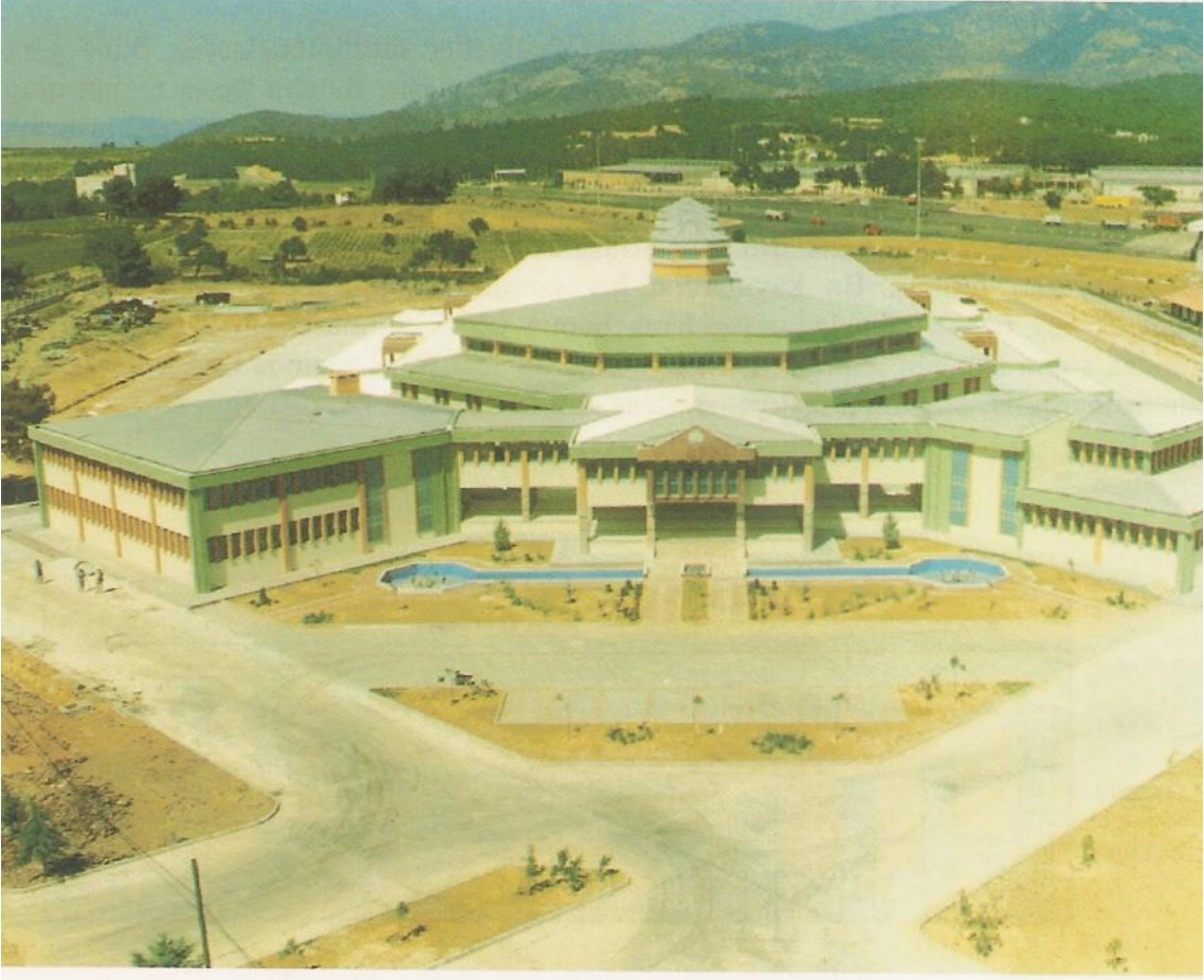
BALIK HALI MÜDÜRLÜĐÜ DİŐ GÖRÜNÜM
