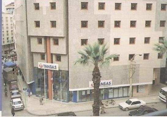
• Alsancak İş Merkezi İnşaatı
