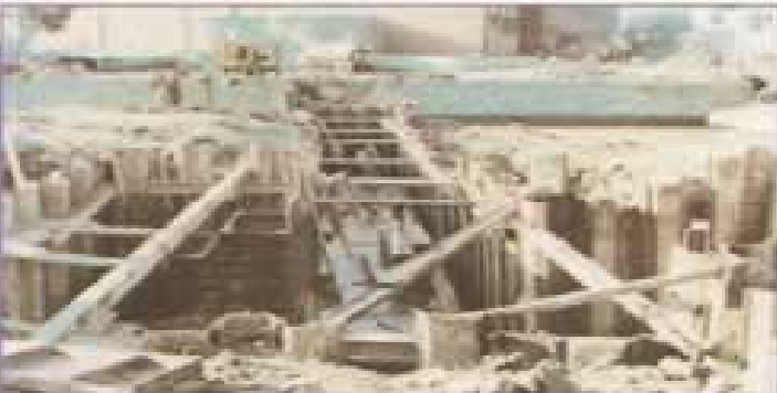
• İzsu Su Borusu Döşeme Çalışmaları
