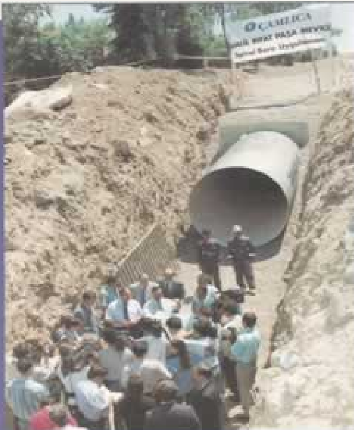
• Çamlıca Hattı Rıfat Paşa Meydanı Spiral Boru Uygulaması
