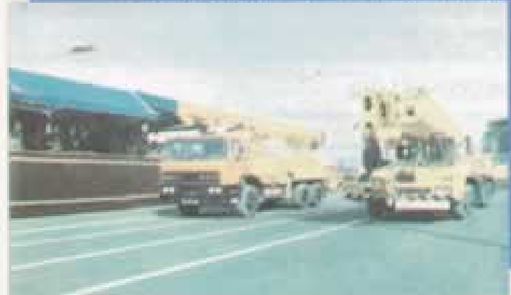
• Beton Pompası ve Yığılma Töreni
