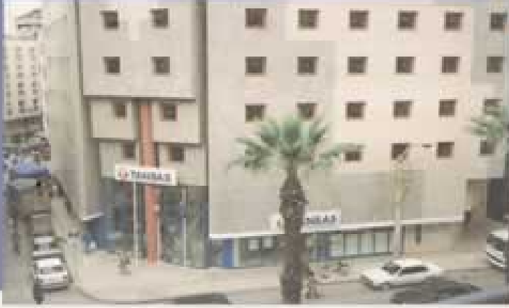
• Alsancak İş Merkezi İnşaatı
