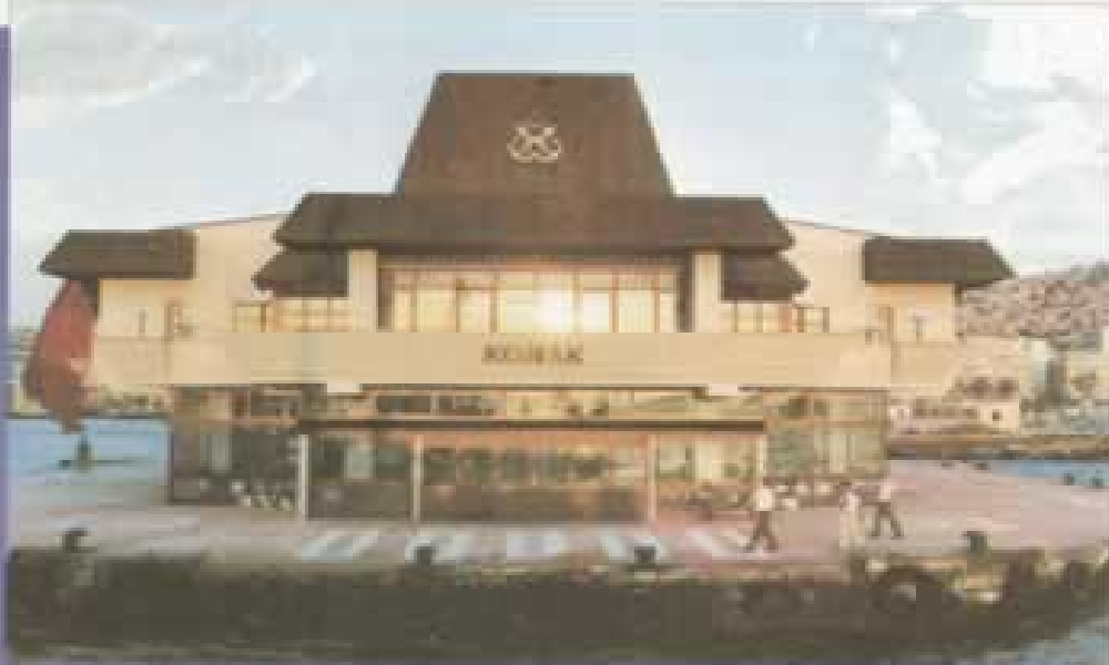
• Konaç iskelesi ve yardımcı tesisleri Büyükşehir Belediyesi, Türkiye Denizcilik İşletmesi ve Kayalar A.Ş. nin ortak çalışmaları sonucu güzel İzmirimize kazandırılmıştır.
