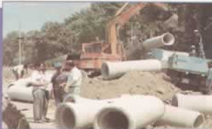
- İZSAŞ Metro Altyapı Depolama Çalışmalarından
