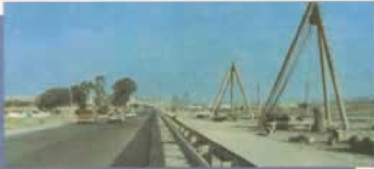
• Naldöken Pompa İstasyonu - Çiğli bölümünde sürdürülen fore kazık çalışmaları
