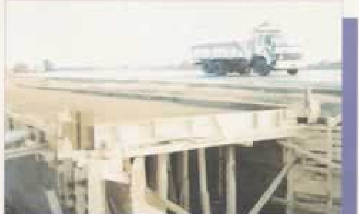
• Karşıyaka - Çiğli Evka-2'ye bağlantı yolu için yol ve menfez inşaatı. (24.01.1996)
