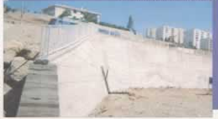
• Egekent 8619 Sokak Denizciler Sitesi arkası istinat duvarları çalışmalarından
